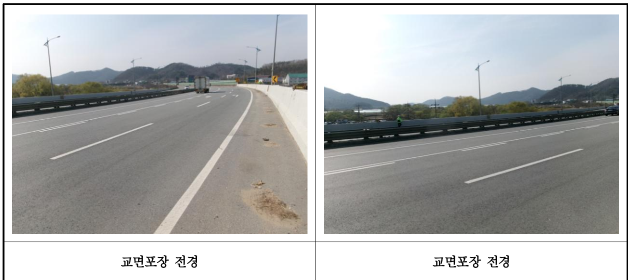
【사진 1.3.19】 교면포장 전경
