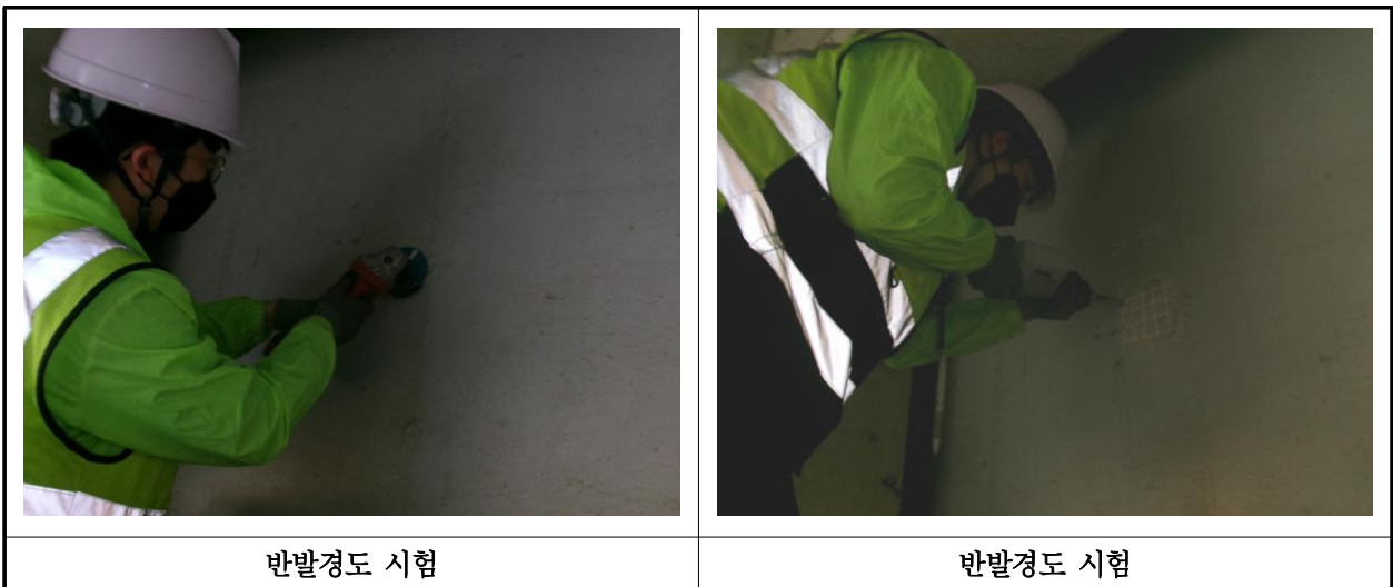
【사진 1.4.1】 반발경도시험 현장사진
