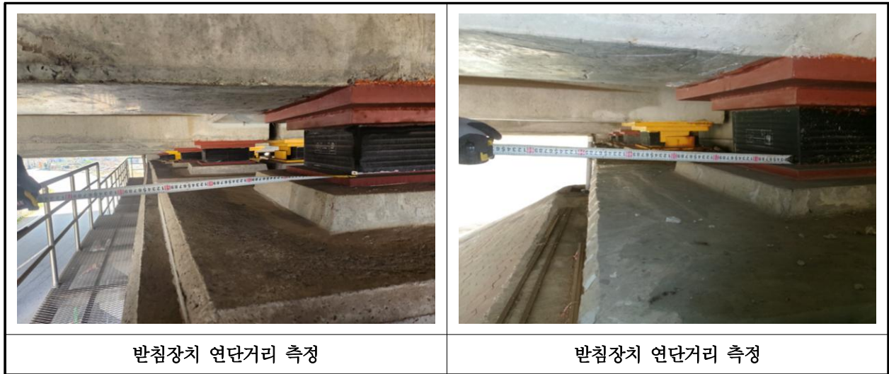
【사진 1.3.14】교량받침장치 연단거리측정
