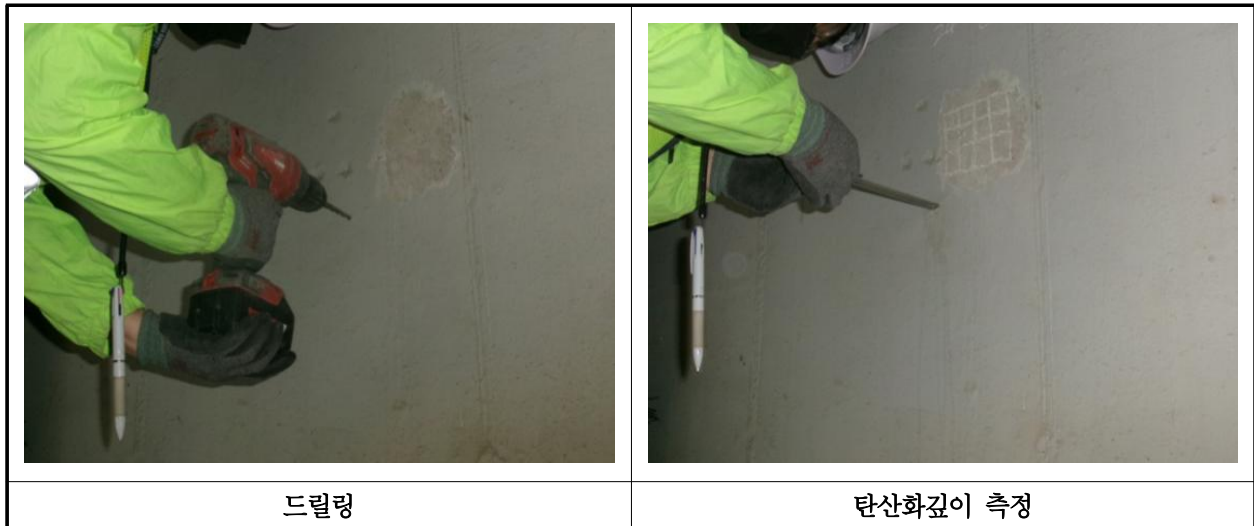
【사진 1.4.2】 탄산화 깊이 측정 현장사진
