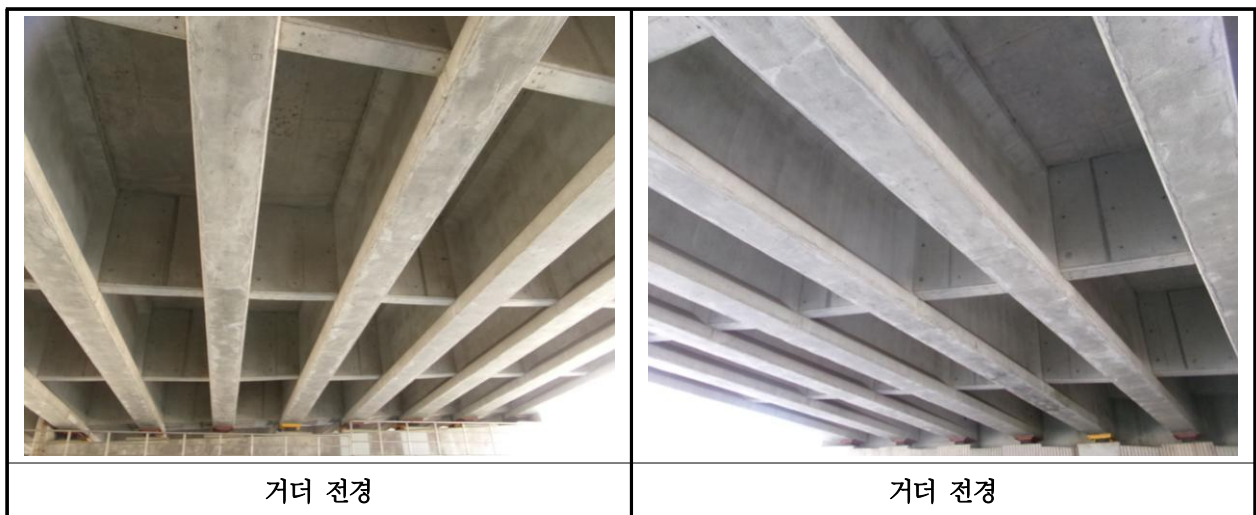
【사진 1.3.4】 거더 전경
