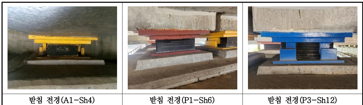
【사진 1.3.12】 교량받침 전경
