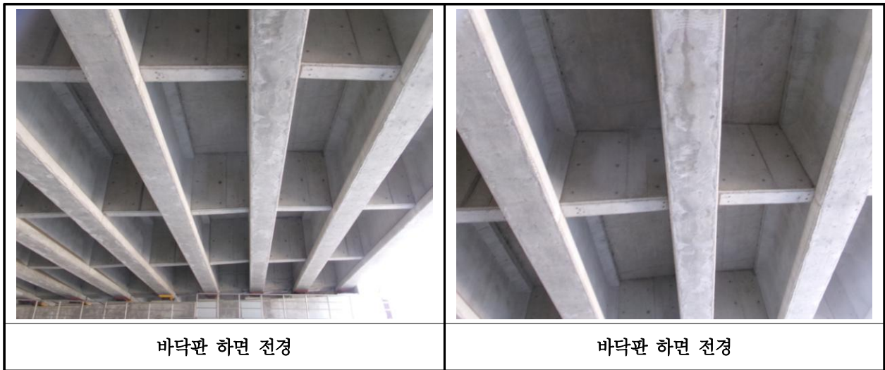
【사진 1.3.2】 바닥판하면 전경
